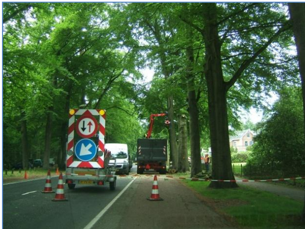
Werkzaamheden aan de beuken langs de Lut. Gen. van Heutszlaan (bomenhoofdstructuur),
